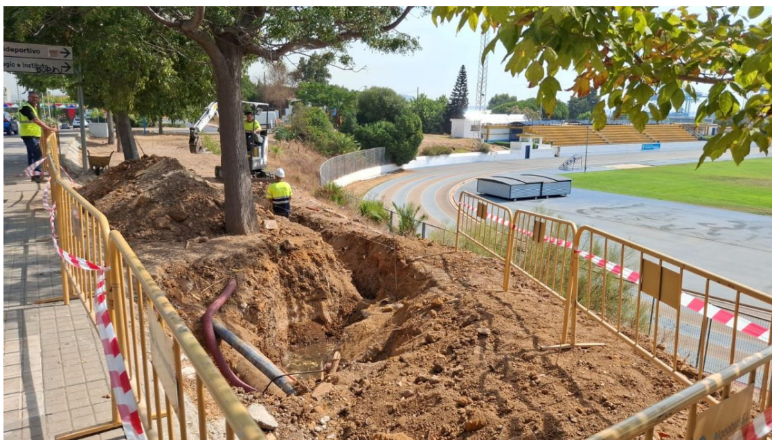
Un momento de los trabajos junto a la pista de Atletismo, en Algeciras.
