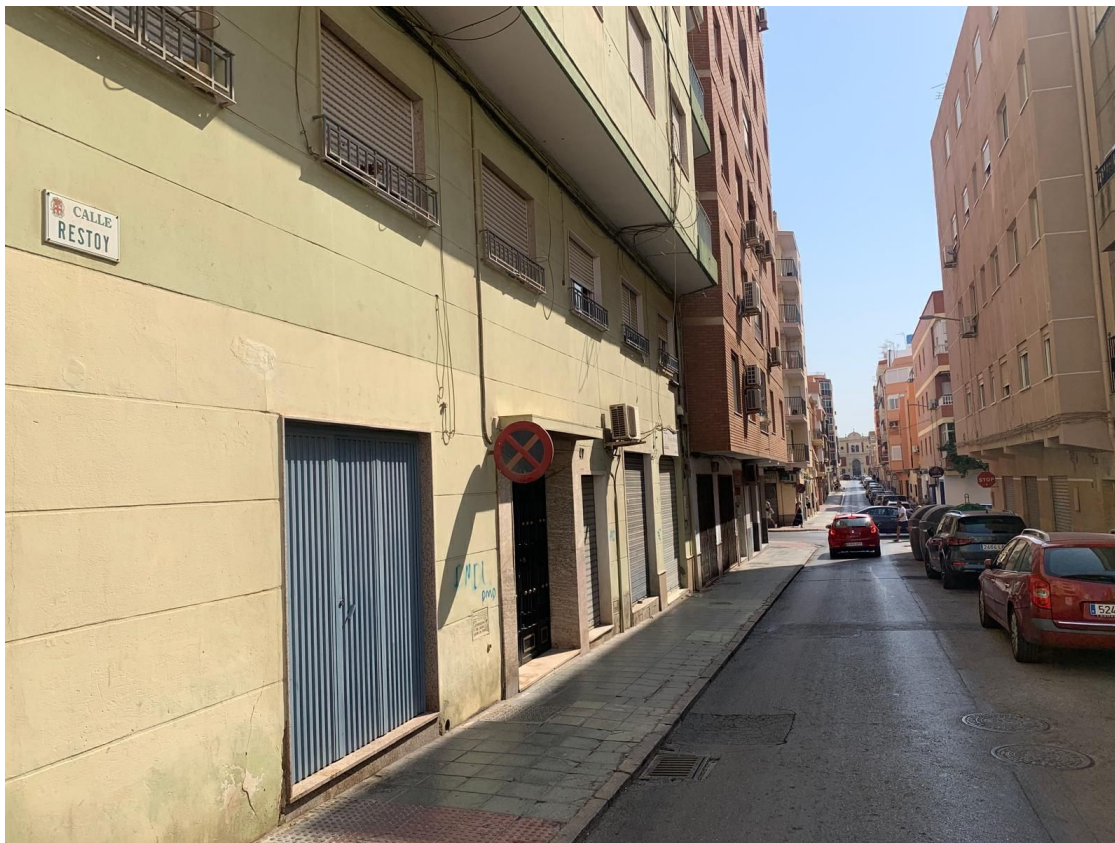
Calle Restoy en la que se realizarán los trabajos
